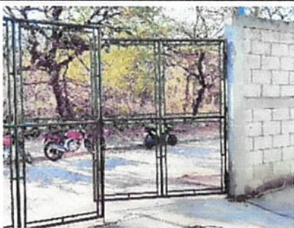
Foto 5: Mejoramineto de Porton ingreso principal
