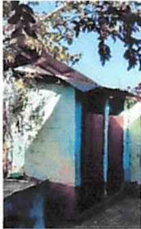
Foto1: cambio de techo, remosamiento de puertas, instalacion de servicios sanitarios
