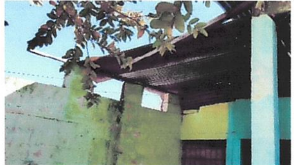
Foto 2: Cambio de techo en area de bodega de cocina, cambio de chapa
