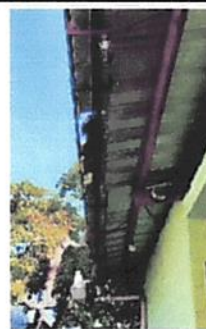
Foto 6: Cambio de canal y colocacion de Bajada de agua
